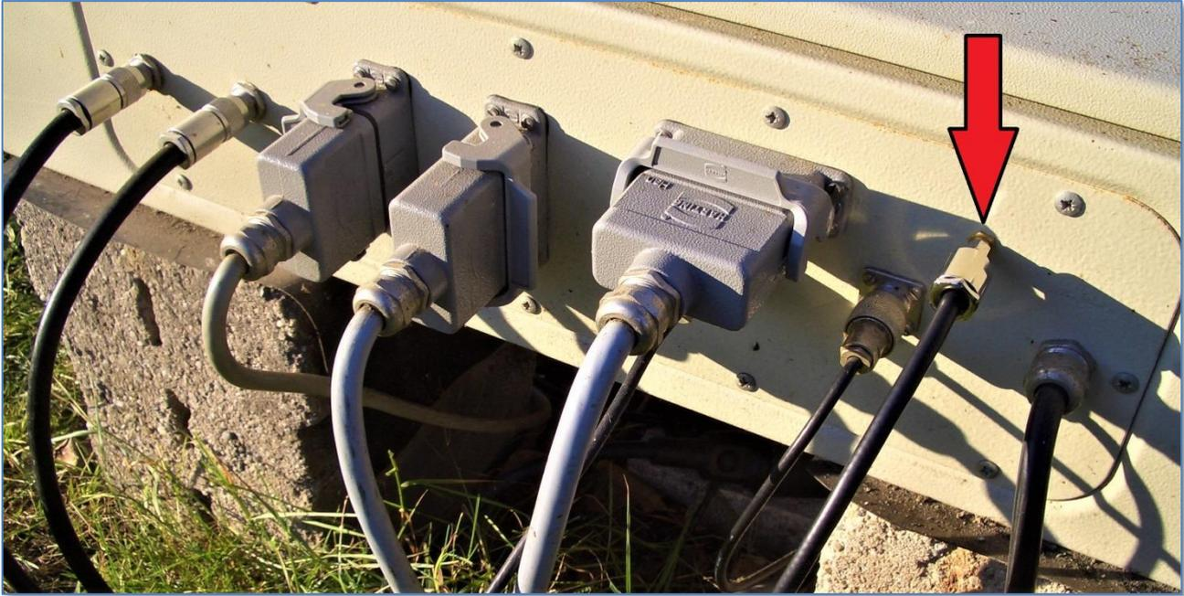
*Und wieder ein Loch mehr, wenn auch nur ein kleines (siehe roter Pfeil) – Probeverschraubung des neuen Kabels am Rittal Schaltschrank*
