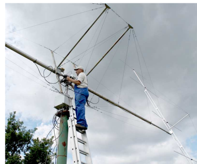
Jarda, OK1RD při upgradu rotátoru pro 2x9el YU7EF (50 MHz EME)
