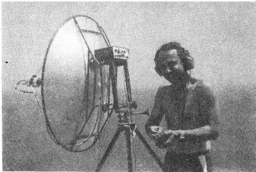
Nicola I0SNY/IC8 telegrafuje při svém rekordním spojení v pásmu 24 GHz. 1984
