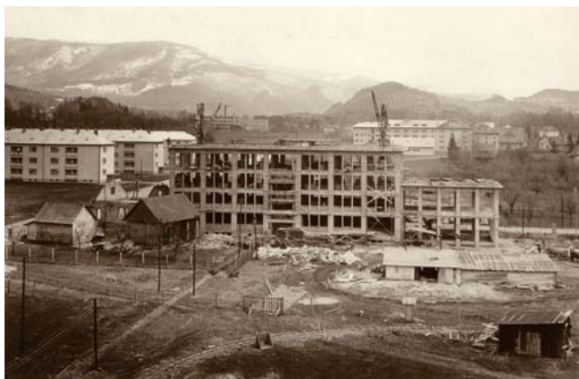
Železobetonový monolitický skelet budoucí administrativní budovy
