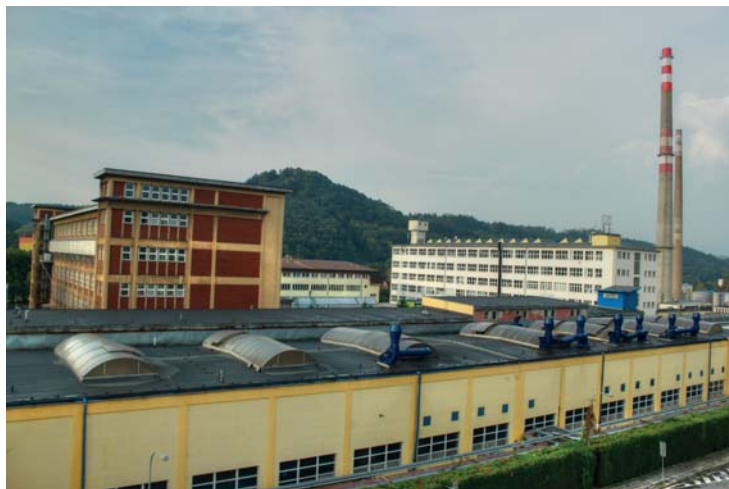
Pohled na opravené objekty nejstarší části areálu
