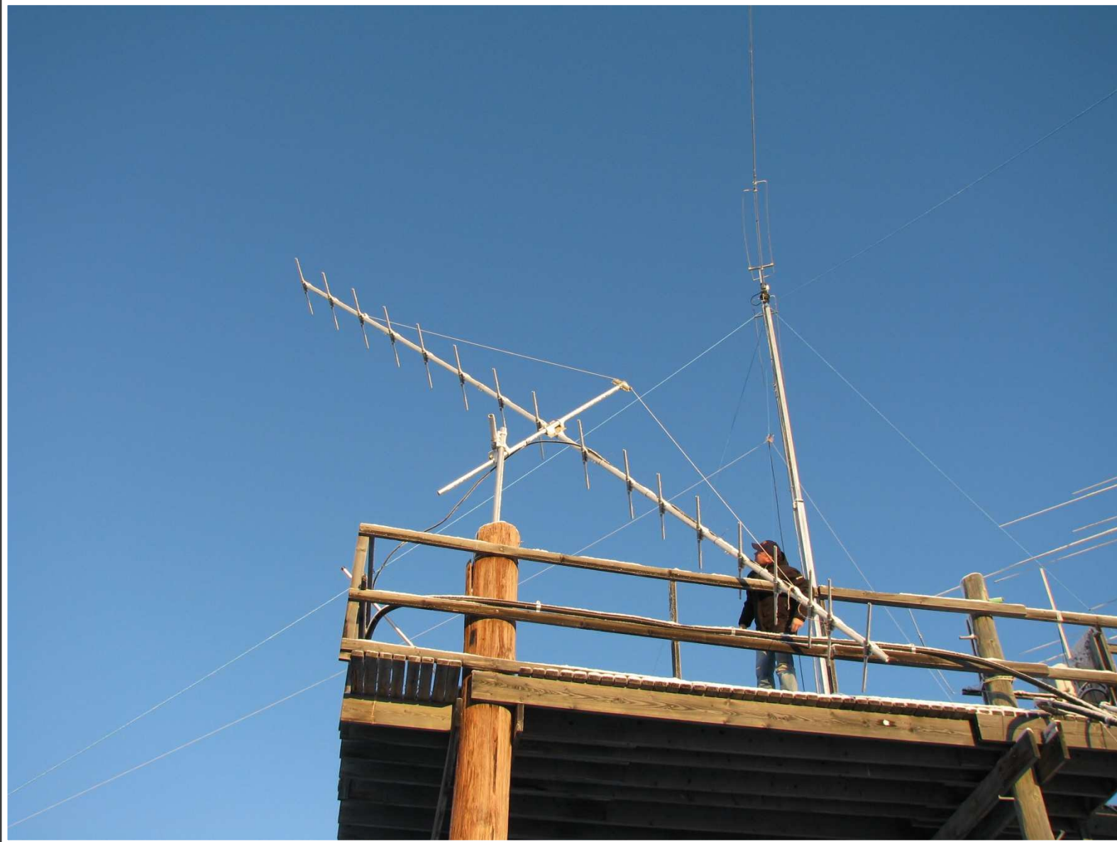
Interference se zábradlím
